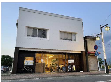
空き家改修事業
