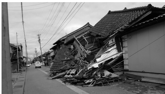
図-3 田鶴浜地区内の被害 (2024 年 2 月 9 日撮影)
