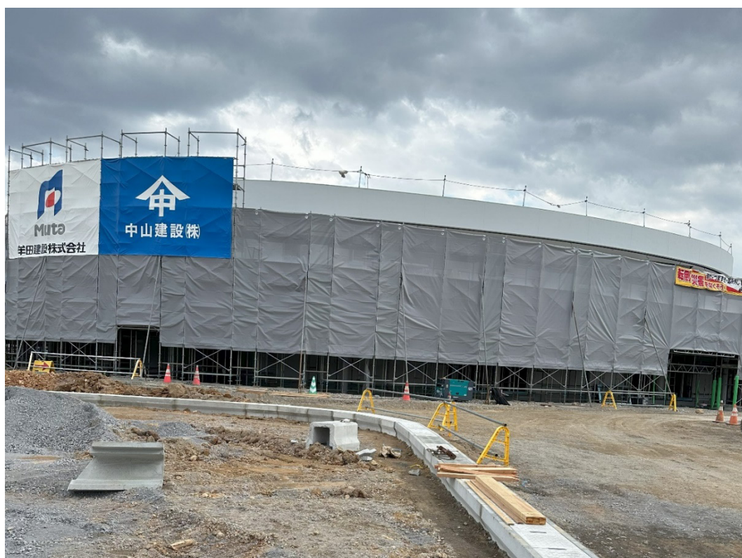
図 19 道の駅建設現場（2024 年 12 月 17 日撮影）
