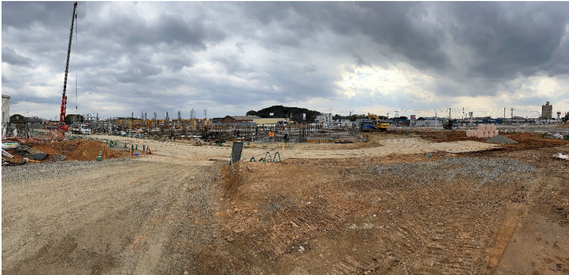
図 20 町営住宅建設現場（2024 年 12 月 17 日撮影）
