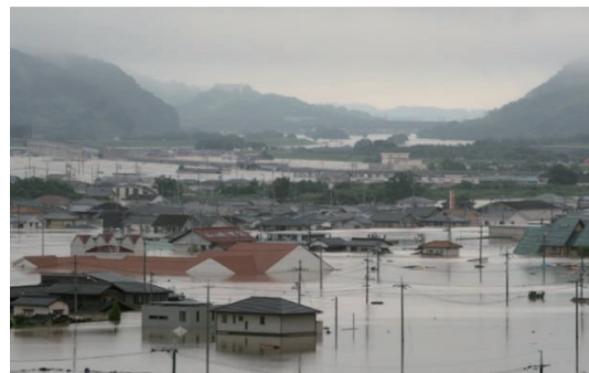
図 22 倉敷市真備町市街地の浸水状況
