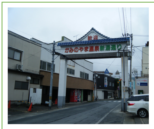
(写真5) かみのやま温泉街入口と解体前のトキワ館
