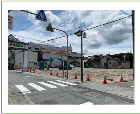
(写真 6) 解体されたトキワ館跡地
