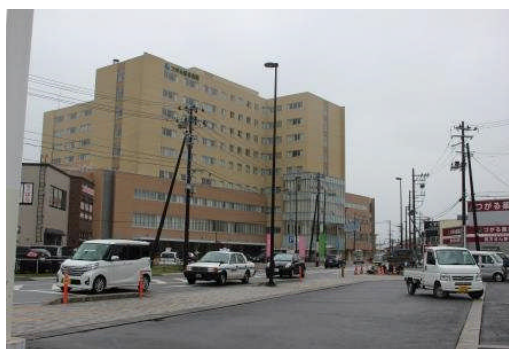
↑市役所駐車場に移転したつがる総合病院
