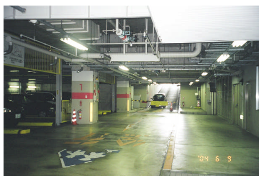
図1 地下駐車場 (1997年完成)
