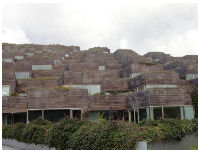
図表 28 VMBJERGET (Mountain Dwellings) (正面、側面写真)
