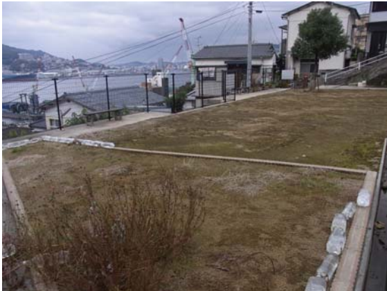
図10 解体跡地例(土系舗装・広場)
