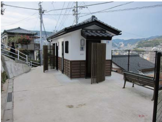
図11 解体跡地例(コンクリート舗装・公衆トイレ)
