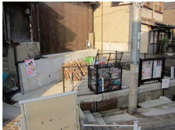
図13 解体跡地例(コンクリート舗装・ゴミステーション)
