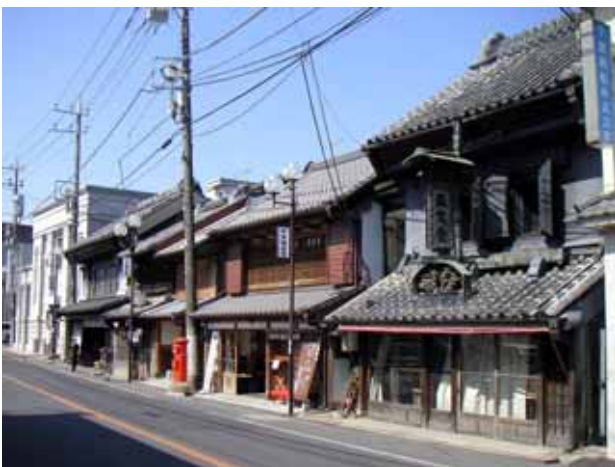
古い建築が残る佐原のまちなみ 2007 年 3 月撮影（以下同じ）
