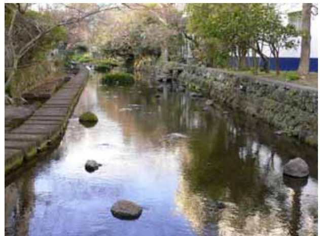
源兵衛川の溶岩護岸
