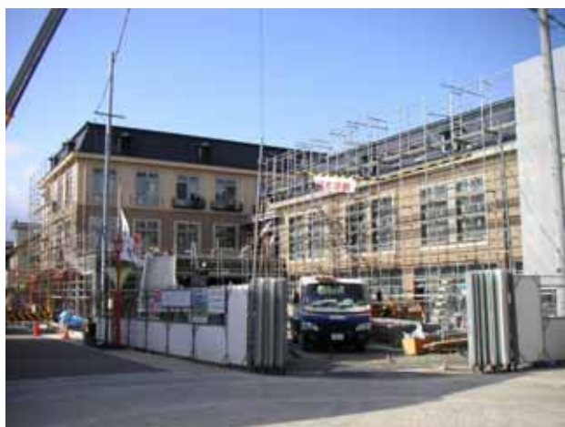
建設中の「食のテーマ館」
