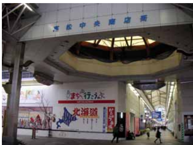
再開発中の丸亀町商店街
