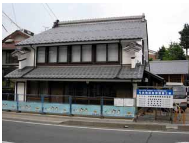
建設中の与良地区町屋館
