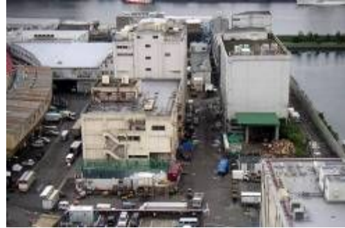
図 - 11 築地中央卸売市場の冷蔵庫周辺
