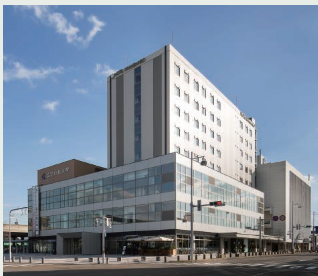
小松駅南ブロック複合施設建設事業 百貨店跡の市有地にホテル・大学・子育て支援施設等を整備 【石川県小松市】(平成29年10月竣工)
