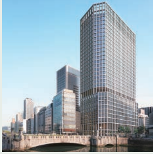
【グリーンアセット等整備支援業務(メザニン支援業務)】 淀屋橋ステーションワン 御堂筋にふさわしい風格を備えた都市空間を創出(令和7年5月竣工)
