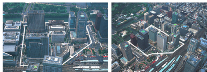
丸の内二丁目地区地域冷暖房区域
