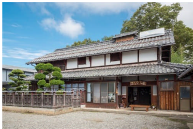
活動拠点の古民家を改修
