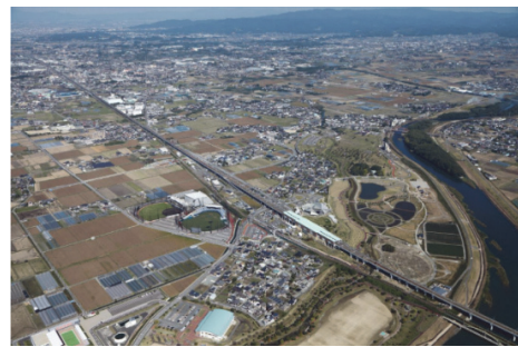
図7 筑後船小屋駅周辺
