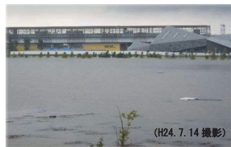
図8 筑後船小屋駅前広場の浸水被害
