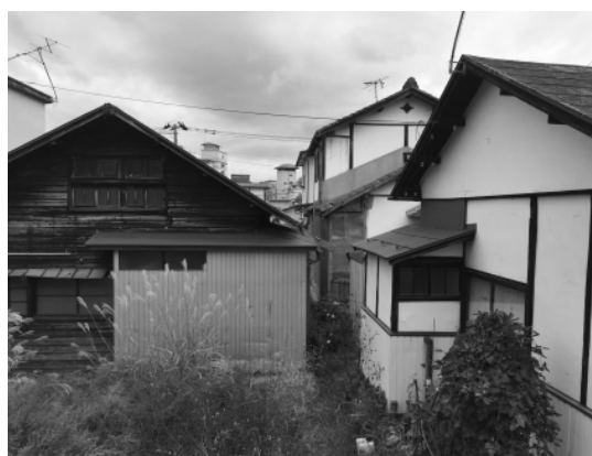
写真2 隣接する空き家群
