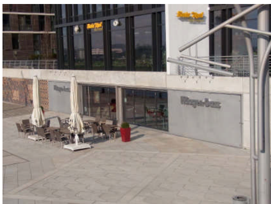
(図5 両側に防水扉を持つ運河プロムナード沿い基準水位下のカフェ 筆者撮影)
