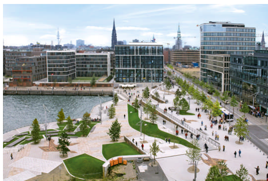
(図7 水際までの4m程度の高低差を連続的に繋ぐランドスケープデザイン 出典： http://www.gardenblog.pl/przestrzenie-publiczne-zwrocone-ku-wodzie-hafency )
