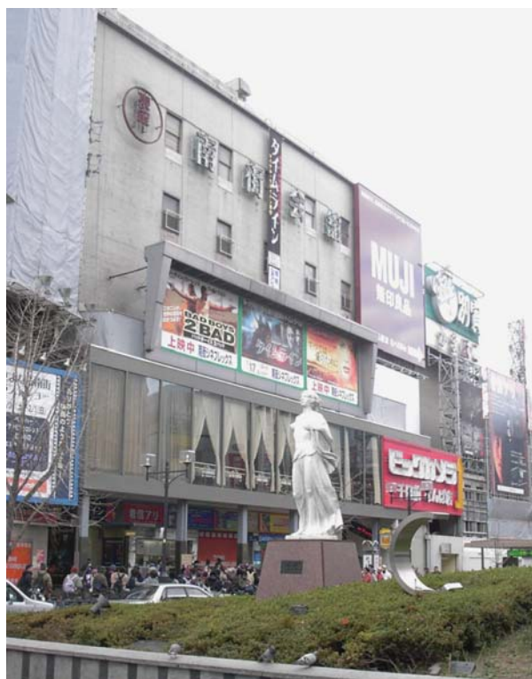
写真4 南街会館は2006年に建替り「東宝南街ビル」に銘板が引き継がれた
