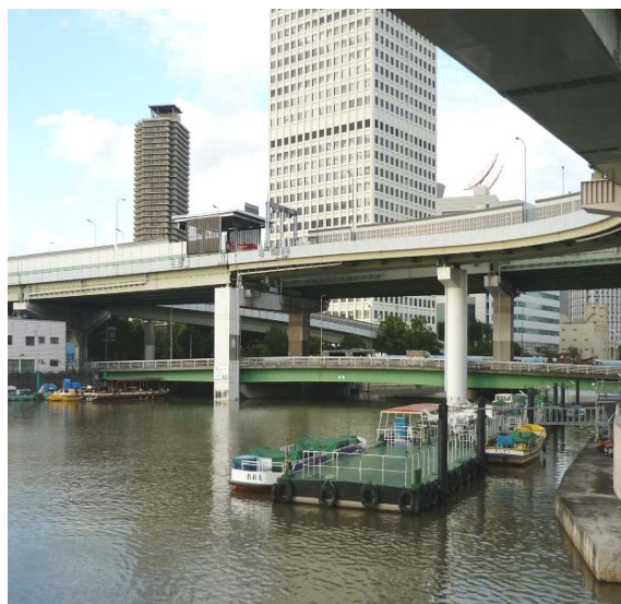
写真7 湊橋付近は観光船が水面を、ビルや高速道路が空を覆う
