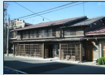
歴史的建造物を活用して 体験型観光施設として改修
