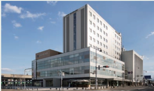
【まち再生出資業務】 小松駅南ブロック複合施設建設事業 百貨店跡の市有地にホテル・大学・子育て支援施設等を整備(平成29年10月竣工)
