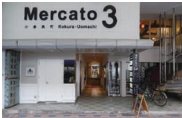
写真③ 古い空きビルをクリエイターの集合アトリエとショップに再生(北九州市内)
