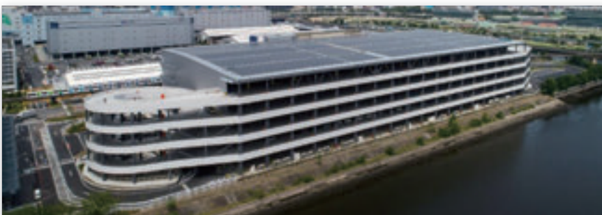
屋上全面に太陽光発電設備を設置
