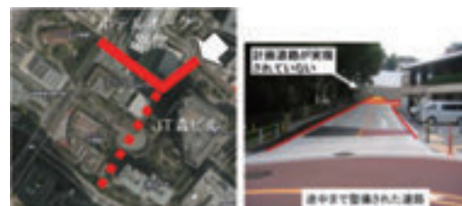
沿道の開発が計画どおりに進まず、地区施設が未整備のままとなっている事例
