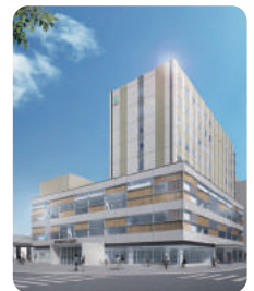
小松駅南ブロック複合施設 建設事業 (石川県/小松市)
