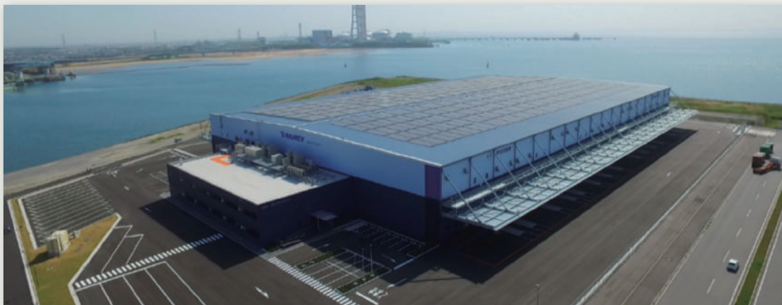
霞北埠頭流通センター全景 (屋根上に太陽光発電パネルを設置)
