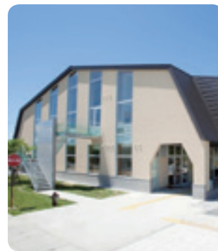
オガールプラザ整備事業 (岩手県紫波町)
