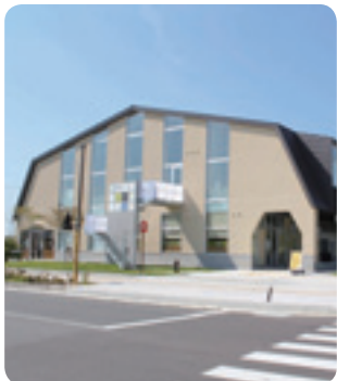
オガールプラザ整備事業 (岩手県紫波町)
