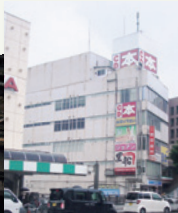
建物全景 (中央4F部分)
