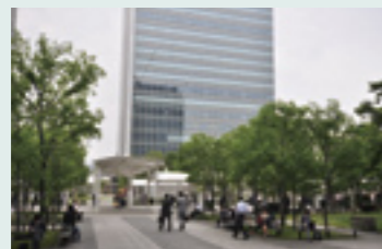
有明セントラルタワー
