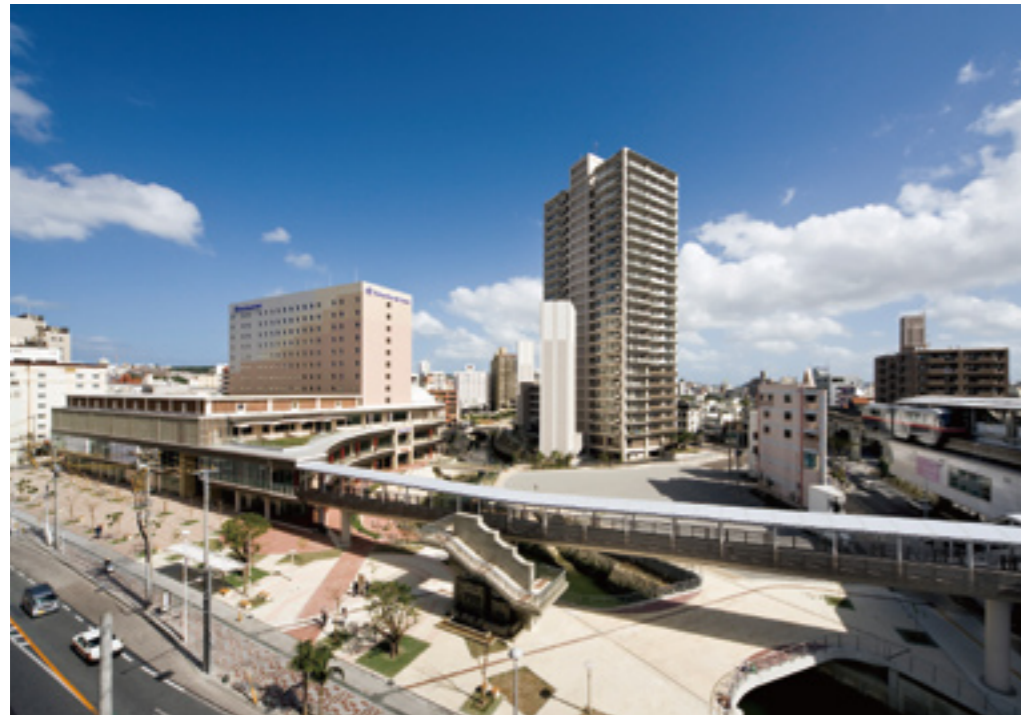
竣工後の事業地一帯
