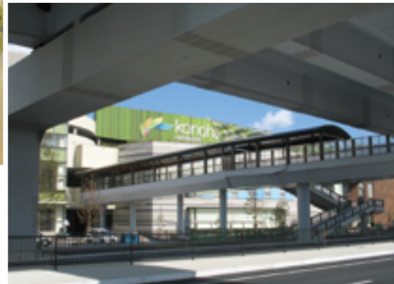
道路(上:高速5号線、下:外環状道路)を跨いで駅に連絡するデッキを整備
